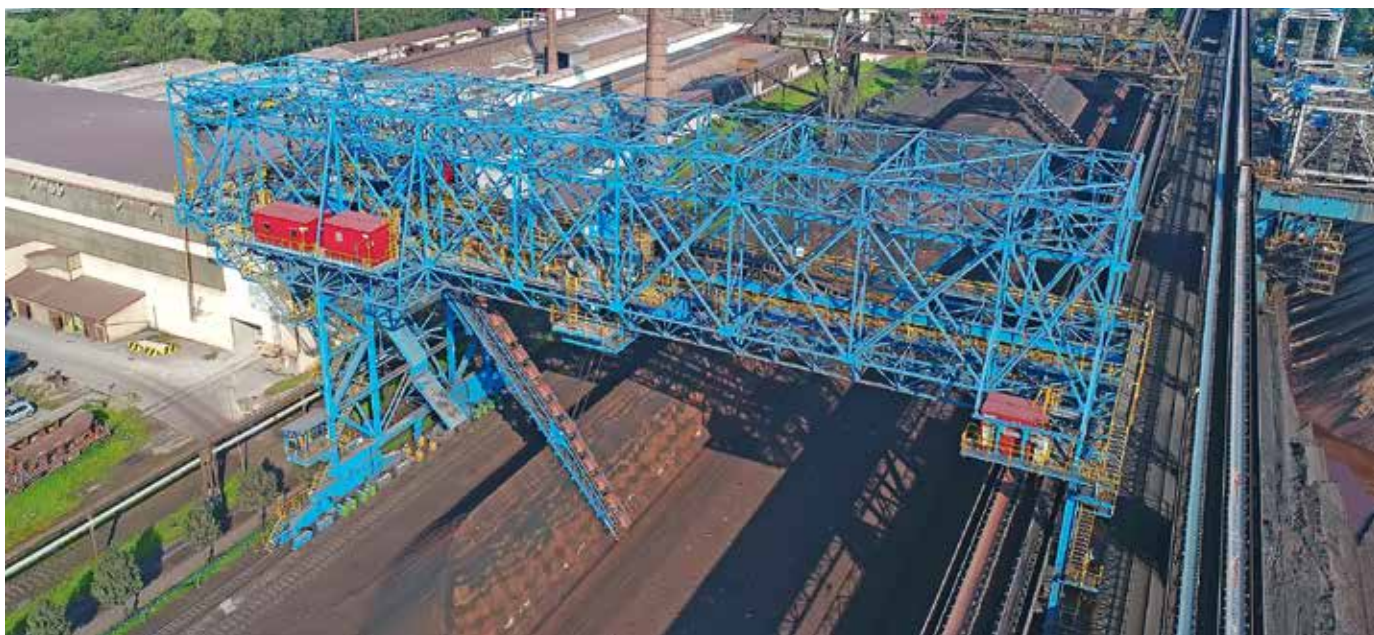
Рудный реклаймер производительностью 1200 т/час на усреднительном складе Тршинецкого металлургического завода (Чехия)
